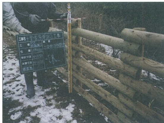
写真64 国有林丸太防風柵(国有林 1134 林班 2004) 酒田市十里塚～赤川河口の管理道沿いに設置 (写真:庄内森林管理署)
