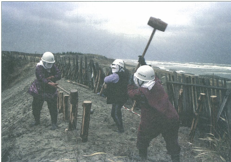
写真10 女性作業員による丘頂垣の杭打ち作業(酒田市十里塚 1986) 上記写真9の作業中 杭打ちは3人が1組になり、かけやを用いて行なわれた。 息の合った作業はスピード感に溢れ、まさに名人芸である。(写真: 梅津勘一)
