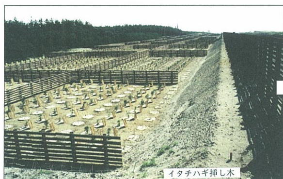
写真33 造成、植栽直後 (1995.3)
