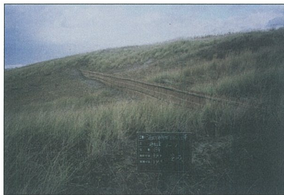
写真17 砂丘垣による風食地の補修 (酒田市浜中) 国有林治山事業 1134 林班 (写真: 庄内森林管理署)
