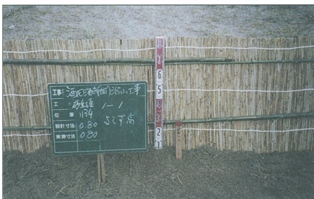
写真11 堆砂垣（砂丘垣）施工例 国有林治山事業 (写真：庄内森林管理署)
