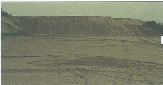
写真31 内陸側(造成後) 1974
