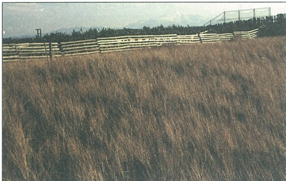
写真26 約10年後の状況
