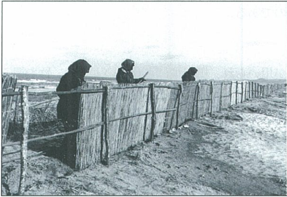
写真12 よし簀取付け ※ 国有林 海岸砂地造林事業 1142 林班
