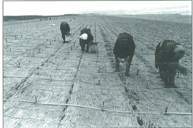
写真21 静砂木植栽状況 ※
