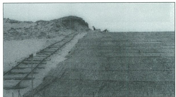
写真19 整地工後に伏工を実施 ※
