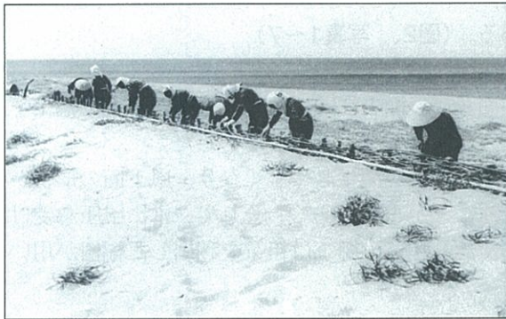
写真2 防浪垣設置状況（遊佐町十里塚付近 1950年代後半）※ 国有林 海岸砂地造林事業 1141 林班
