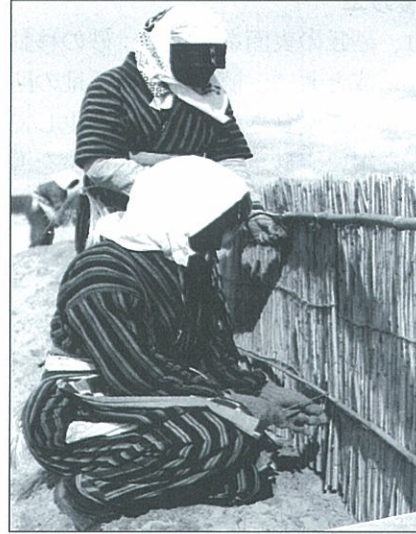
写真13 押竹取付け ※
