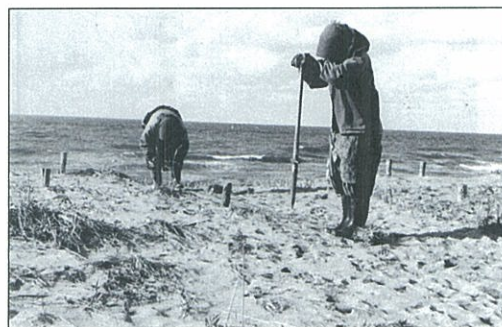
写真45 専用の案内棒(酒田式)を用いた植栽 ※
