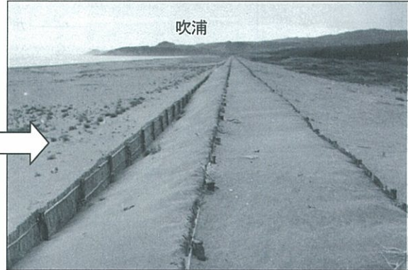
写真15 同左 複数列施工後の堆砂状況 ※ 国有林 海岸砂地造林事業 1142 林班 (遊佐町十里塚北 1950 年代後半～60 年代前半)
