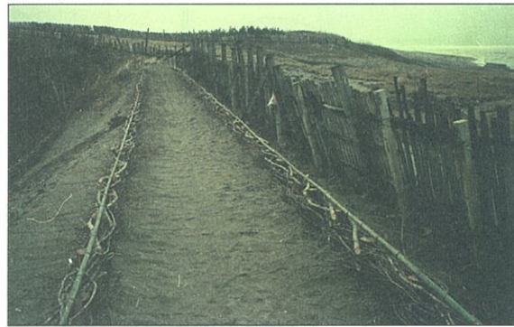
写真9 局部的補修の丘頂垣施工例(酒田市十里塚) 民有林治山事業(保安林改良) 1986 (写真: 庄内総合支庁森林整備課)
