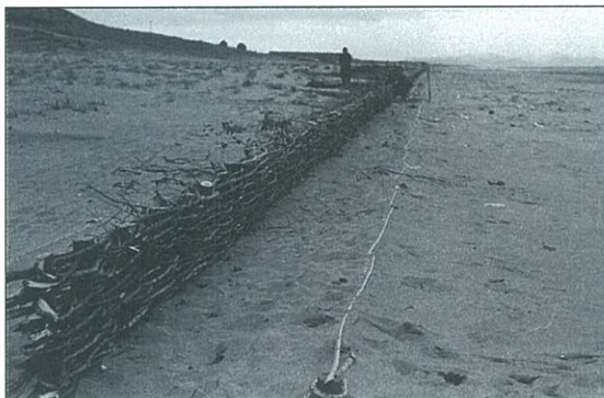
写真4 防浪砂堤設置状況（2列目設置前） （写真：庄内総合支庁森林整備課）
