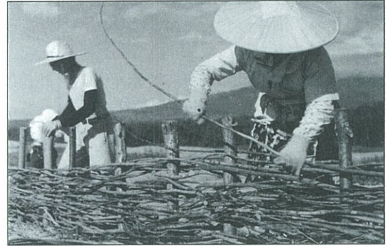
写真3 同左 編柵工 帯梢設置状況 ※
