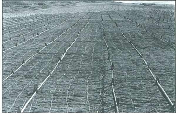
写真23 押竹、押串施工状況 ※
