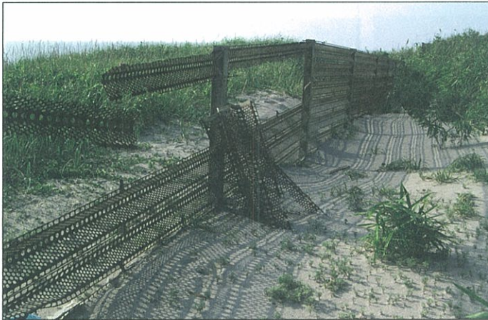
写真61 埋没し破損した鋼製折板柵 (酒田市十里塚 2006.7.30) 鋼製柵であっても永続性はなく、維持管理が必要である。 (写真:梅津勘一)
