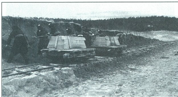
写真18 整地工実施状況(凹凸を整える作業) ※
