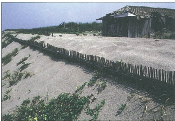
写真16 堆砂垣堆砂状況 (酒田市十里塚) 国有林治山事業 1135 林班 1986. 8 (写真: 梅津勘一)
