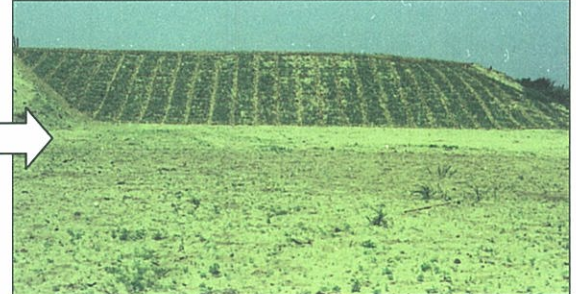
写真32 同左 伏工実施後
