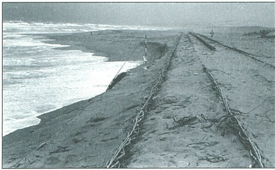
写真6 高潮による防浪砂堤被災状況(遊佐町比子 1960年代民有林治山)
