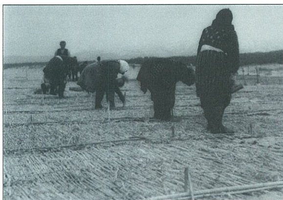
写真20 押串設置状況 ※
