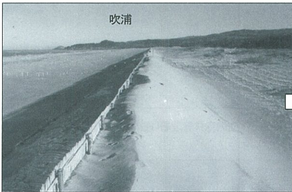
写真14 堆砂垣設置後の堆砂状況 ※ 国有林 海岸砂地造林事業 1142 林班
