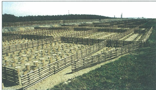
写真62 国有林管理道沿いの丸太防風柵(1134 林班 2006.7.30) 写真63 民有林治山事業(酒田市大浜 1995.3) 木製防風柵 (写真:梅津勘一)
