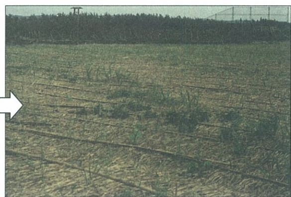
写真25 伏工実施後の植生進入状況
