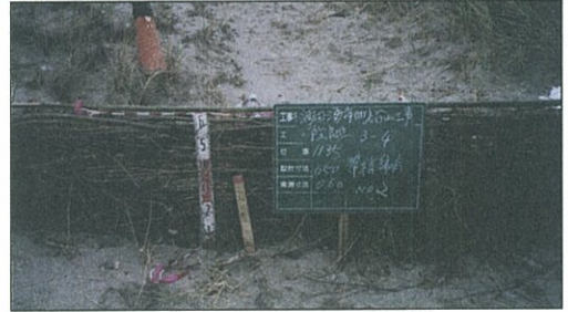
写真1 編柵工施工例（写真：庄内森林管理署提供）
