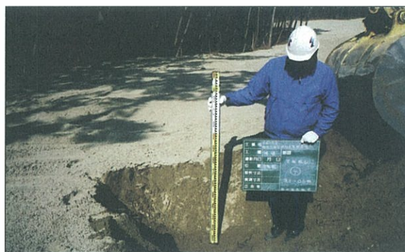
写真56 天地返し状況確認
