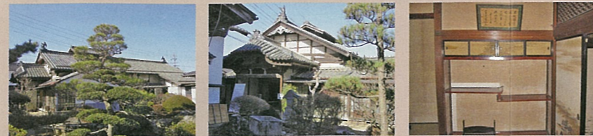
旧芦田宿本陣は、昭和63年(1988)長野県宝に指定された。玄関屋根は切妻造りで正面に唐破風をつけており、座敷部の屋根は妻入瓦葺構造である。内部は建坪80坪に上段の間等を配し、優れた意匠の京風な造りとなっている。
