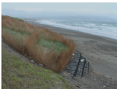
写真 4-5 フトン籠設置による復旧工事
