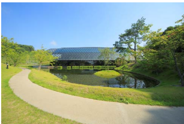
池周辺の遊歩道を社員の憩いの場として利用
