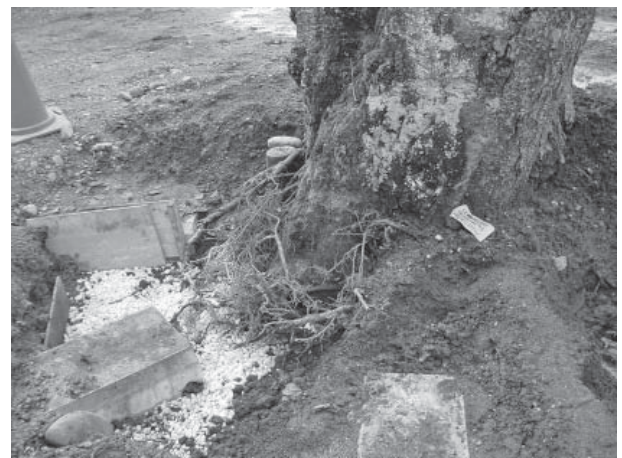
写真8 逆伏U字溝根系誘導工の工事状況。
