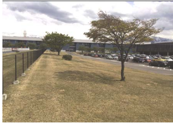
敷地周辺部を芝生で幅広く整備し、一部遊歩道として地域に開放
