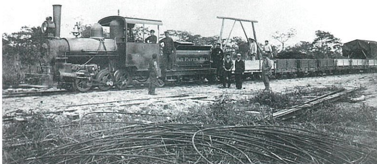
発電所へ資材輸送をする山線
